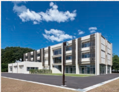
軽金属材料共同研究棟
